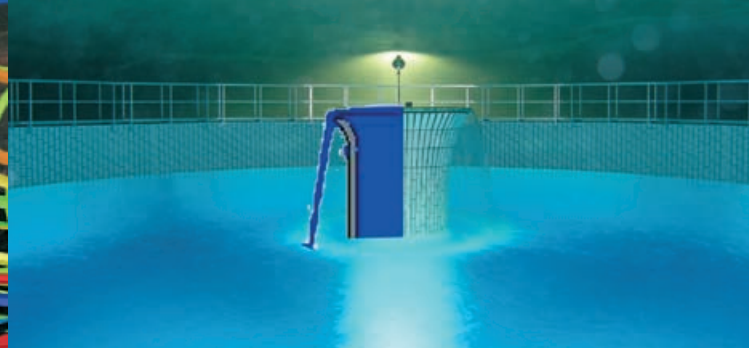
Trinkwasserspeicher – Simulation Einlaufmulpe
